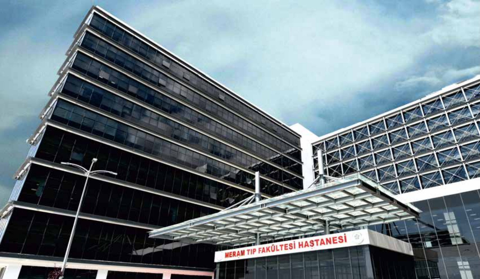
Все низковольтные панели были произведены AFB Energy.
