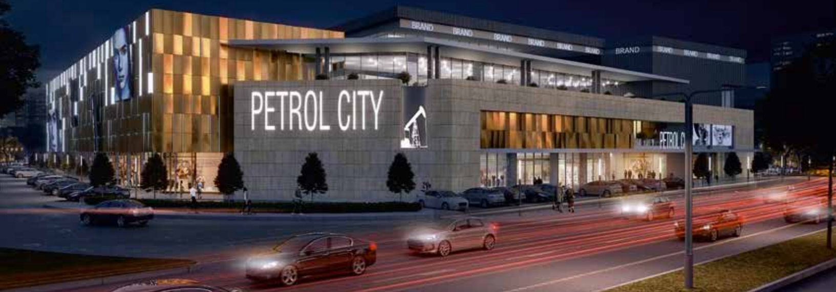
Все низковольтные панели были произведены AFB Energy.
